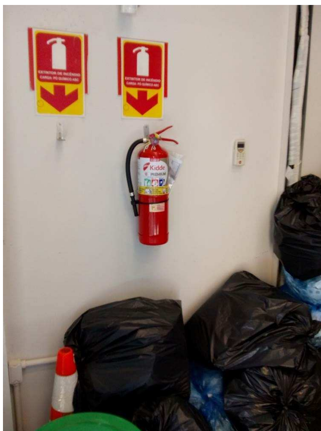
Foto 14 - Sinalização de prevenção contra incêndio (Necessário Substituição)
