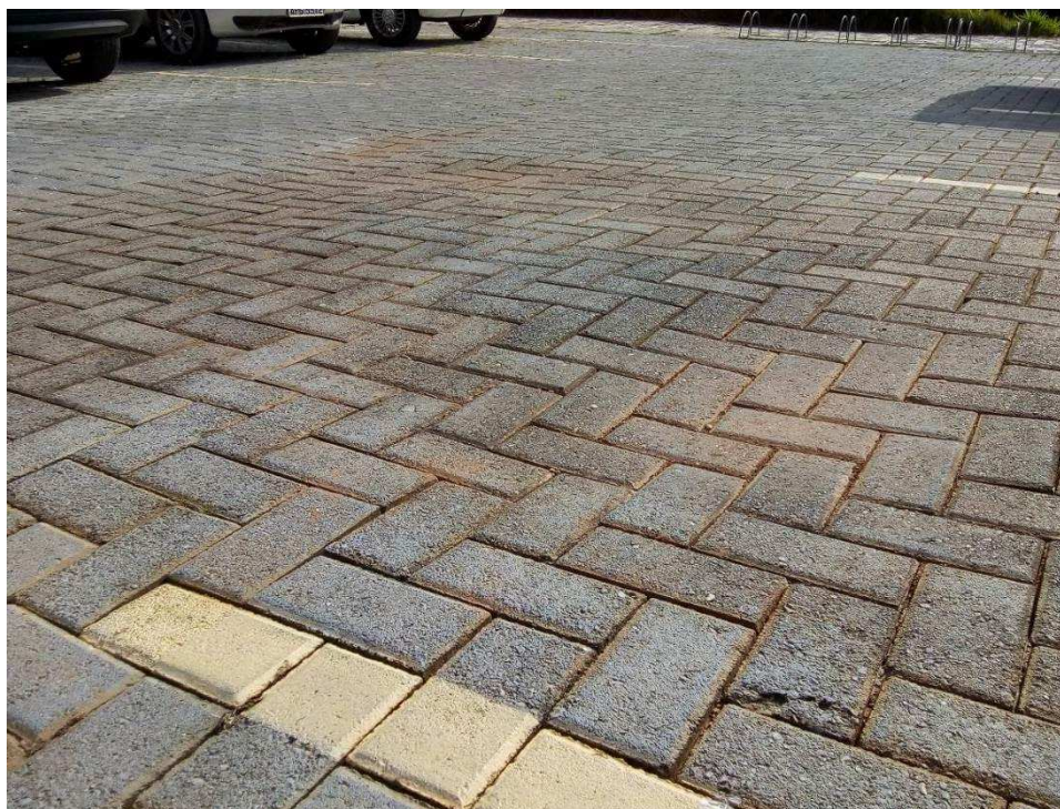
Foto 17 - Recalque pavimento do estacionamento
